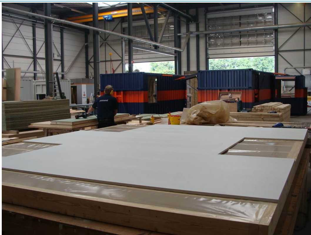
Foto C.2 Balklaag voorzien van dampremmende folie en deels PROMAXON® (vuurzijde)
