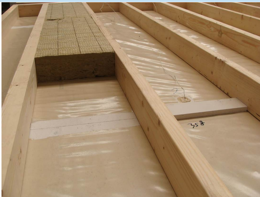
Foto C.4 PROMAXON® -type A aan onderzijde, tijdens isoleren tussen balklaag
